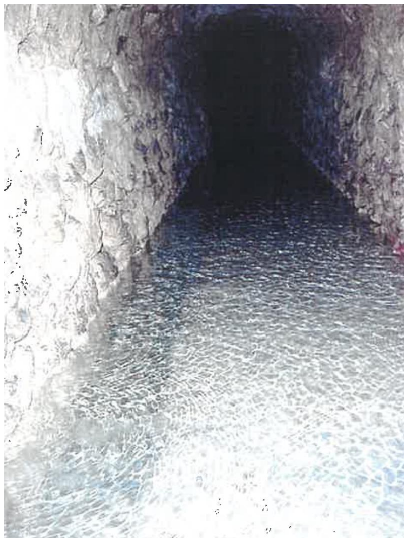
Tronçon vers la rue de la voûte (béton fait obstacle l'eau s'écoule sur toute la largeur de la galerie)
