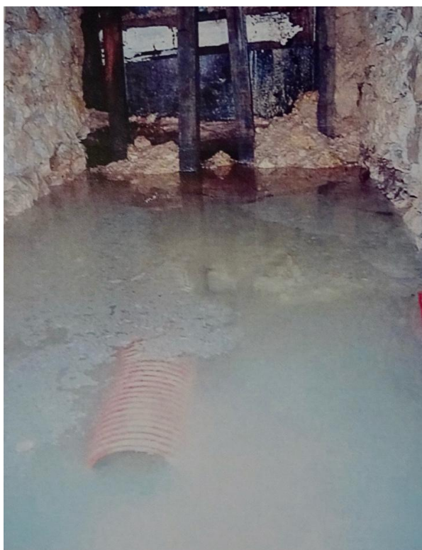
Fin de la galerie Est (K) : comblée et canalisée
