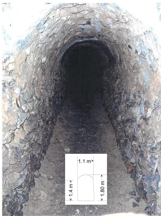
Fin de la galerie Est (K) : comblée et canalisée
