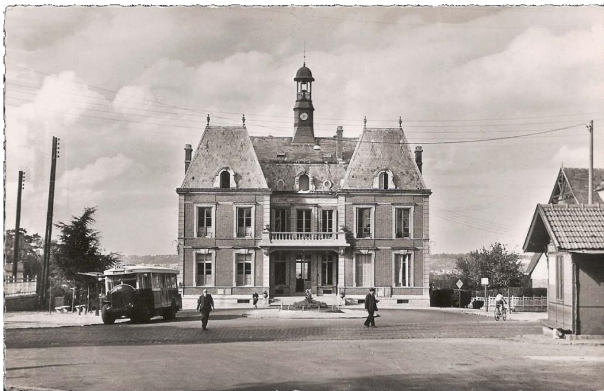
« La mairie » - La mairie avec clocheton, balcon et inscription « LIBERTÉ - ÉGALITÉ - FRATERNITÉ » au fronton. Au rez-de-chaussée, deux panneaux d'affichage à droite et deux à gauche. À gauche, le bus 120, TN6C2 n° 2864, est stationné devant son arrêt : la photo a été prise avant août 1953 (date de création du 220 donc le 120 ne venait plus à Noisy). À droite, on voit encore l'ancien terminus du tramway. Deux hommes, une femme et un cycliste traversent la place. (CPSM dentelée non datée , la même circulée 1950 ) (édition ? - n° ?) (coll. MJ)
