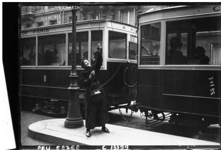
Receveuse accrochant l'extrémité de la perche sur le fil d'alimentation électrique (Agence de presse Meurisse - Gallica-BNF)
